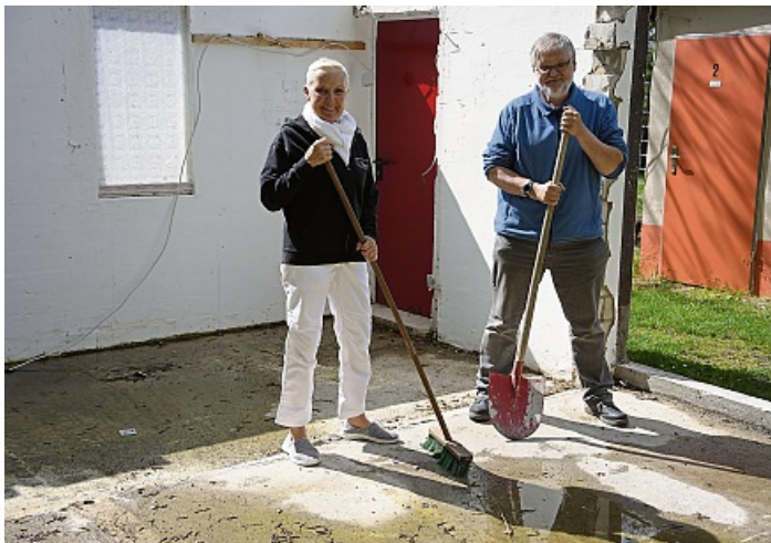
Auf diesem Fundament wird die Quarantänestation für Hunde errichtet.
